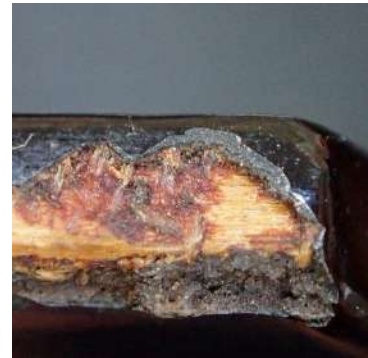
図 3-16 削形付近の塗膜剥落
